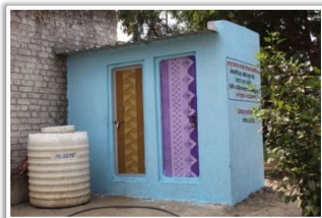
Toilettes avec douche terminées
