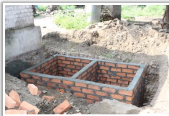
Toilettes à double fosse
