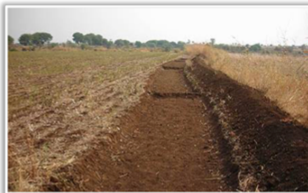
Une des digues du village de Sonawala, permettant de conserver l'eau de pluie
