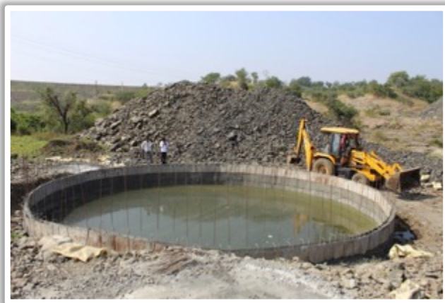
Puits en fin de construction déjà remplis
