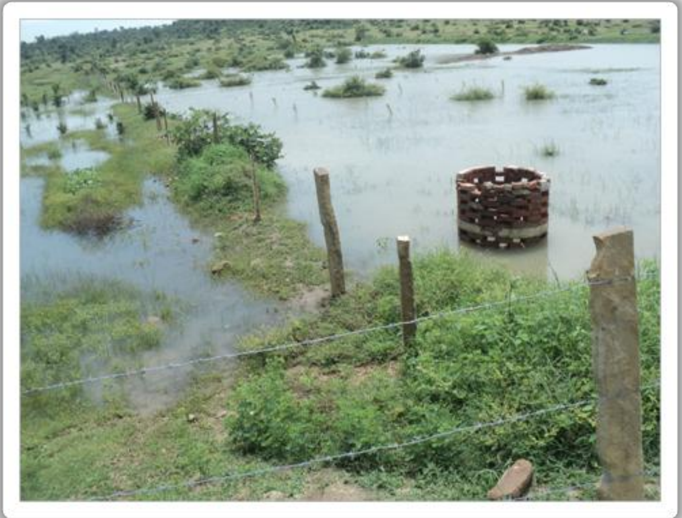
Une averse à fait débordé un des bassins. Les pousses d'arbres sont recouvertes par l'eau.
