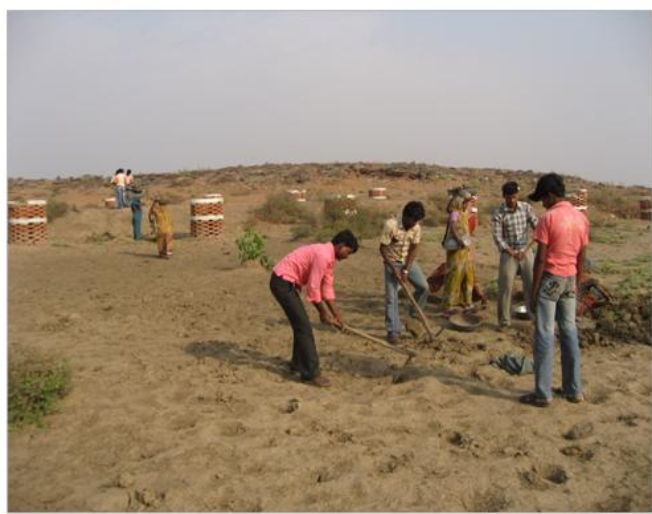
Début des travaux sous la chaleur du mois de mai.
