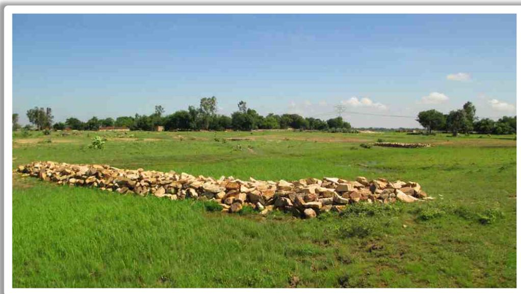
*Ce barrage de correction en pierres que nous avons construit dans le village de Laxmipurva a permis aux agriculteurs d'accroître les surfaces cultivables. Devant les pierres, l'eau et les sédiments s'accumulent, donnant une terre fertile pour planter du riz.*
