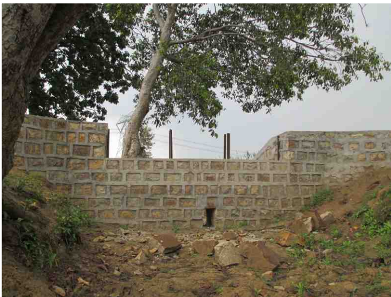
Barrage de correction sur la rivière Palna.
