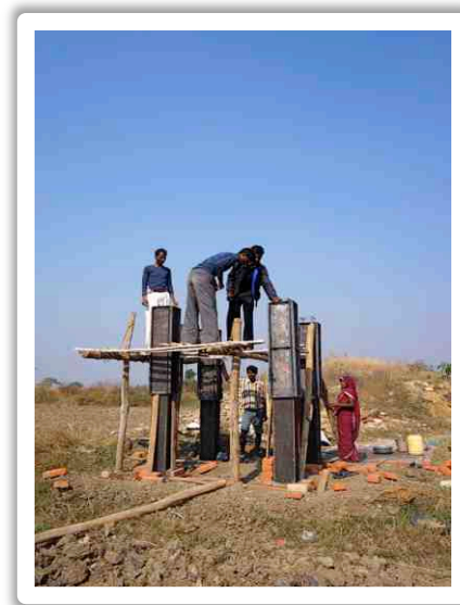
Tank sur piloti dans le village de Chetteni
