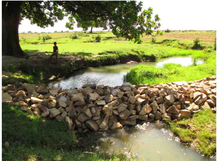
Barrage en pierres qui ralentit l'eau et favorise son infiltration.
