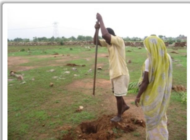
Avec les premières pluies, le creusage a pu commencer
