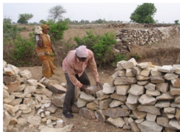
Santosh et sa femme en train de terminer la construction de leur mur.
