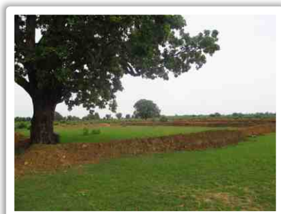
Construction de diguette pour retenir l'eau de la pluie sur les terres agricoles
