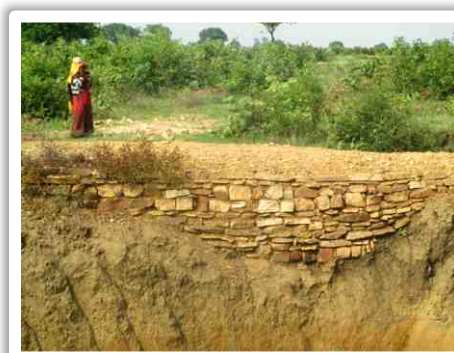
Renforcement des parois mis en place par Ram Balak dans le village
