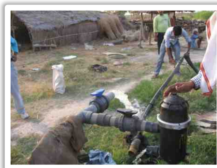
Système d'irrigation goutte à goutte de Mankamana
